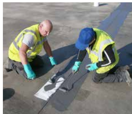
Øverste dæk i parkeringshuset i shopping-centeret RO's torv er efter renoveringen med Triflex flydende kunststofsbelægning helt tæt. Det er udført i flotte mørkegrå og lysegrå nuancer.
