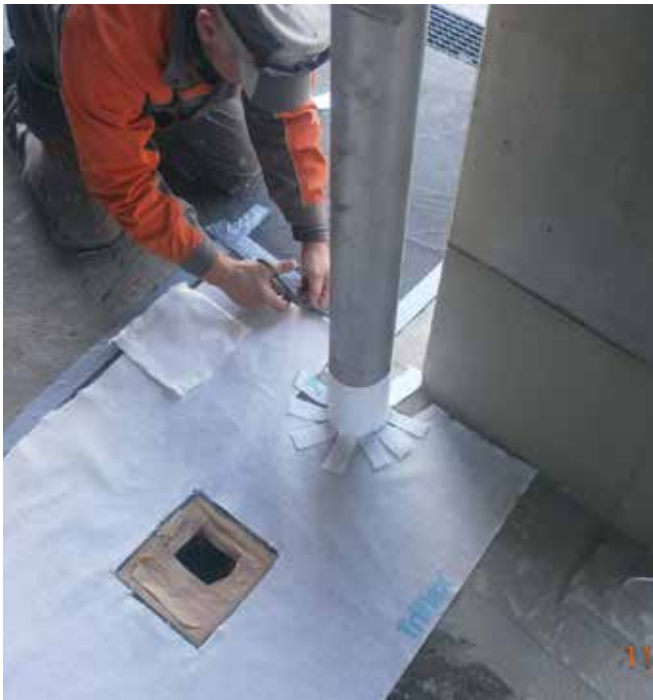
Med tilpasset Triflex specialflies tættnede renoveringsspecialister rør, søjler, afløb og hjørner.
