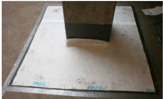
Triflex specialflies sikrer dynamisk dækning hen over revner og sørger for en langtidssikker tætning – også ved bevægelse mellem bygningsdele.
